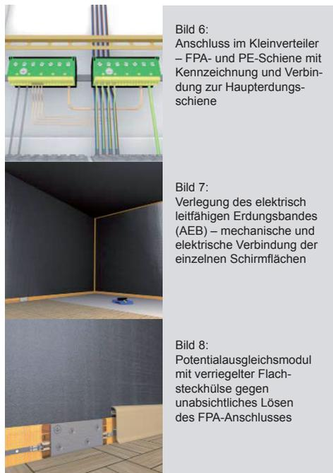
Bild 6: Anschluss im Kleinverteiler – FPA- und PE-Schiene mit Kennzeichnung und Verbindung zur Haupterdungsschiene
